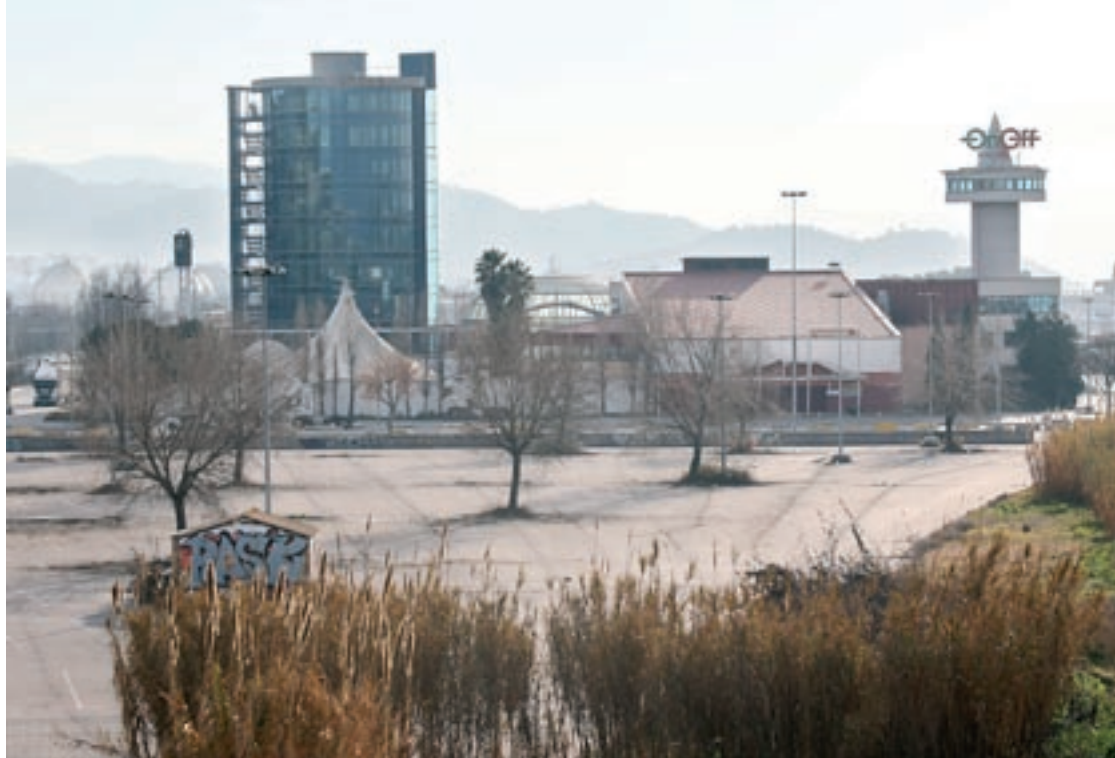
Els terrenys i les instal·lacions de la zona d'oci, que seran enderrocades, sobre els quals s'edificarà el complex logístic
