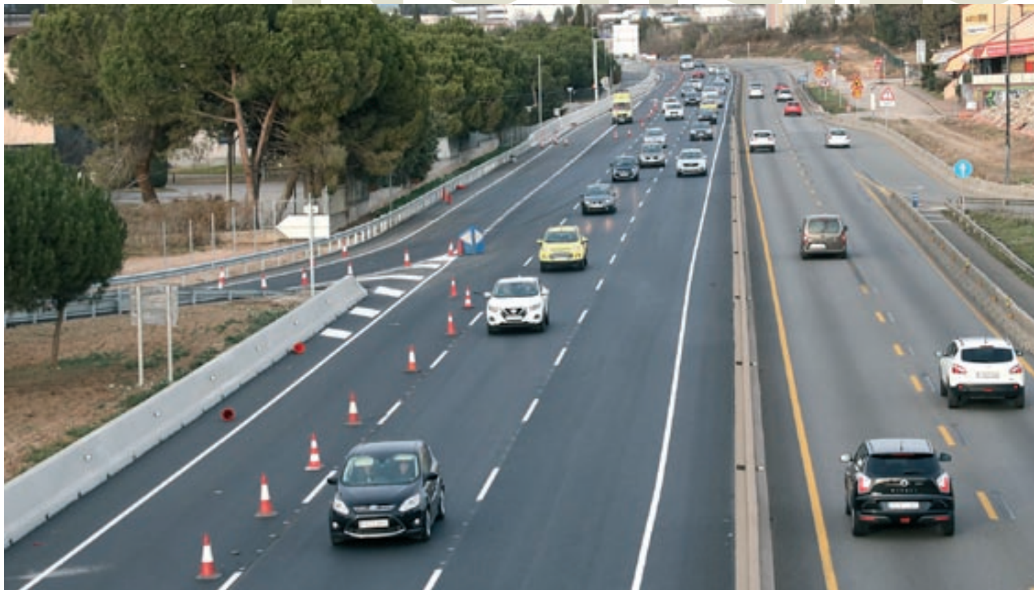
La nova imatge de la C-17 amb els tres carrils en sentit sud des del pont de la carretera Interpolar, a Parets
