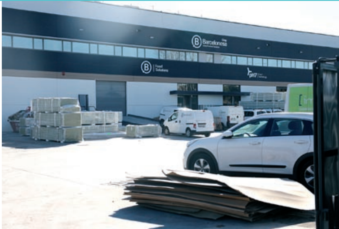
Les instal·lacions que el Grup Barcelonesa està ultimant al polígon Sector Autopista de Parets
