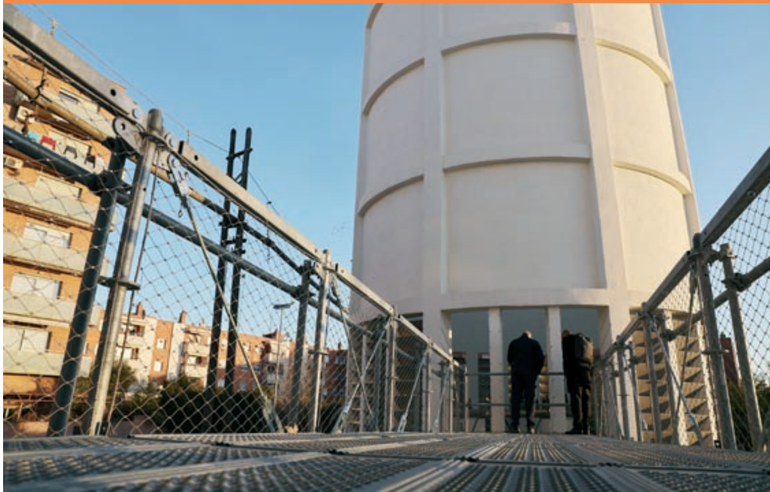
Una passarel·la uneix ara l'espai de La Tèrmica amb el refrescador rehabilitat
