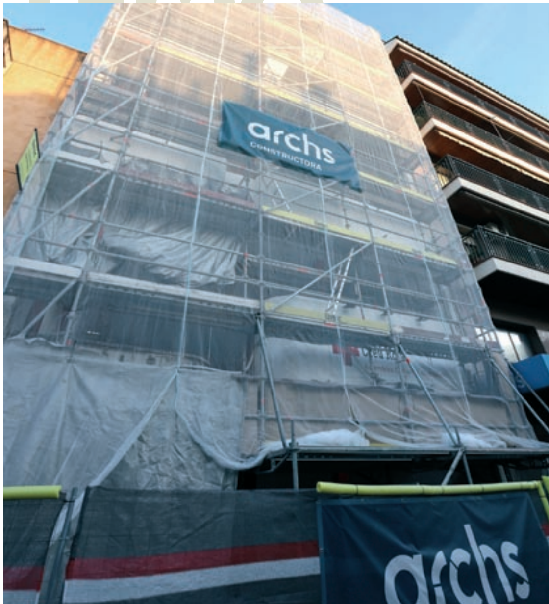
Una bastida cobreix des de la setmana passada l'edifici en obres de la Creu Roja al centre de Granollers
