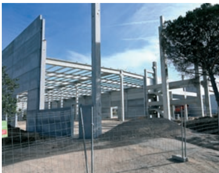
Les obres del centre logístic, en una imatge de fa unes setmanes
