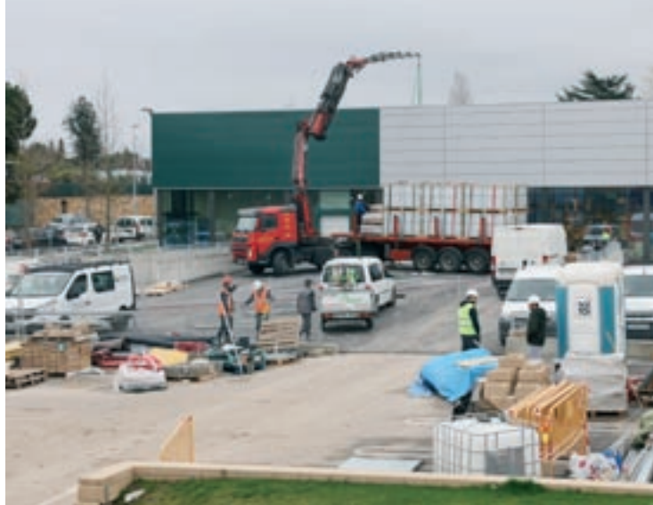
Les obres del nou establiment s'estan enllestint aquests dies
