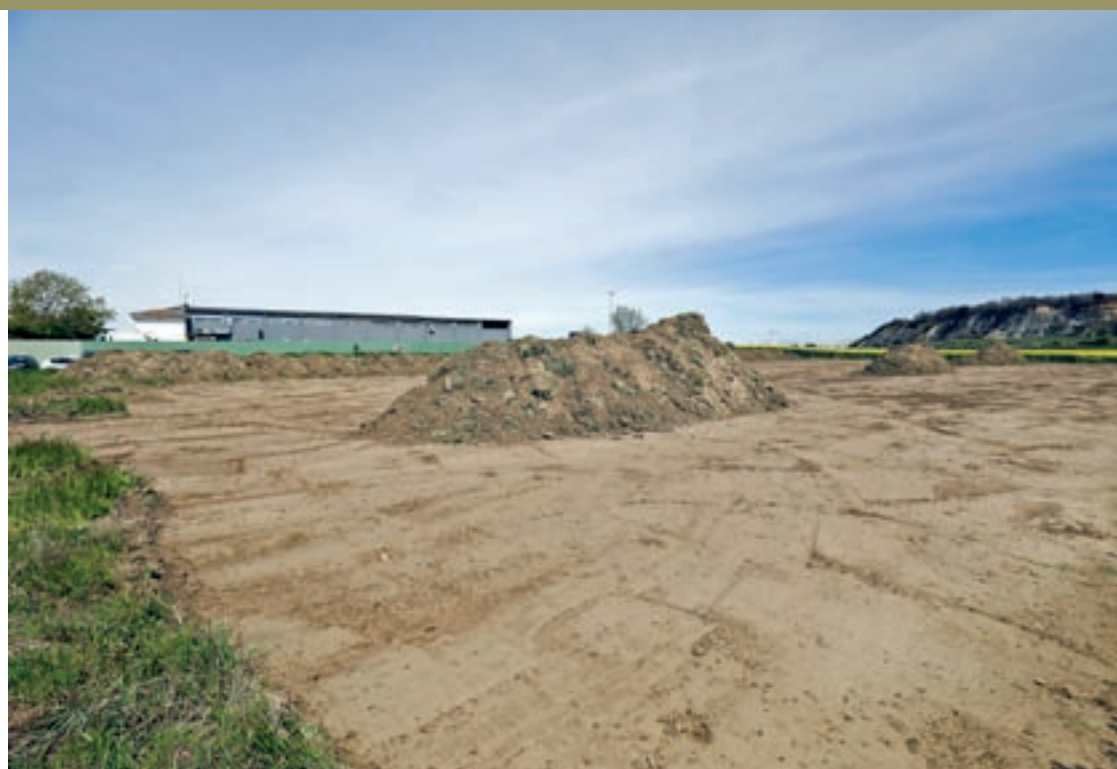
La construcció de la nova planta de compostatge i, al fons, les instal·lacions de la Mancomunitat La Plana
