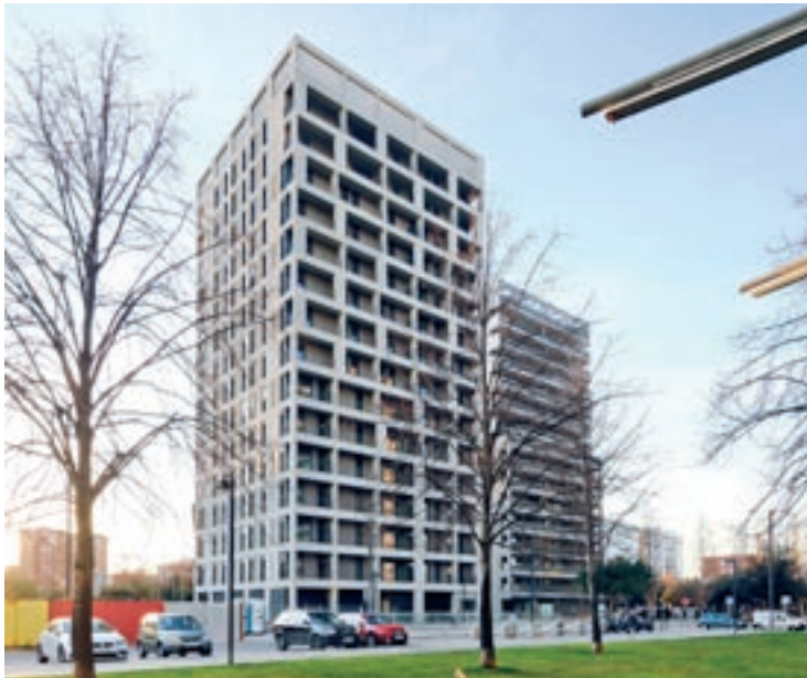
L'edifici de l'Hospitalet de Llobregat on Roansa ha fet l'estructura prefabricada
