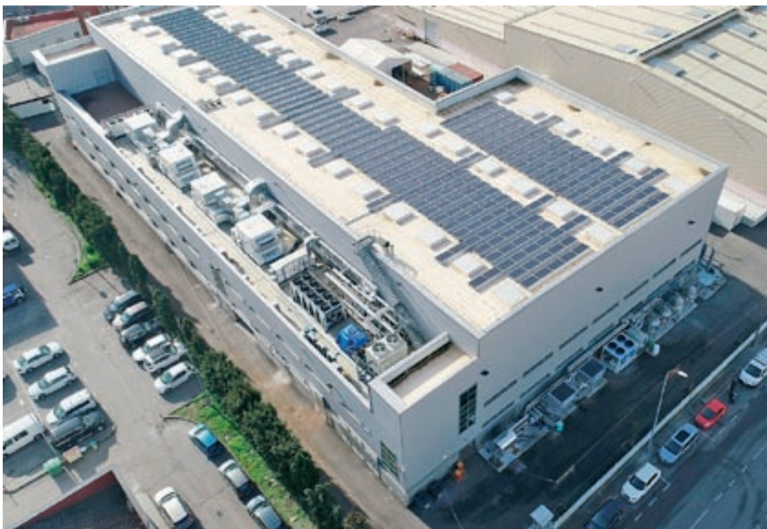
Instal·lacions de Henkel a Montornès, que també incorporen panells solars per generar energia
