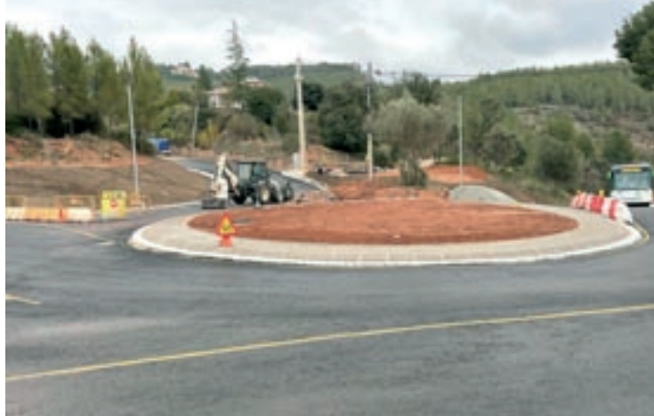
Els treballs no poden acabar-se si no es retiren els suports de les línies
