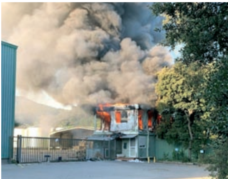
Les oficines cremades eren en uns mòduls prefabricats que van cremar
