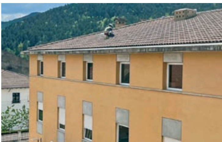
Operaris començant la col·locació de les plaques solars
