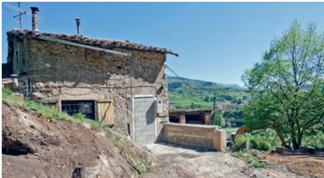
La casa amb la porta d'accés tapiada
