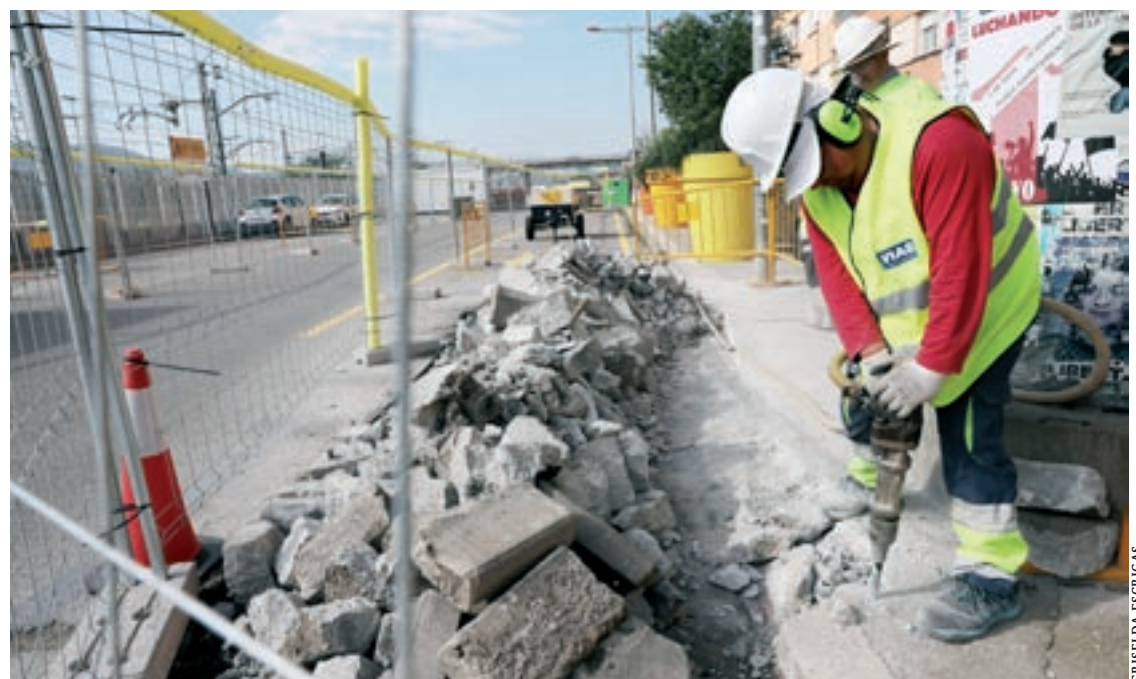
Un operari treballava aquest dijous a l'exterior del recinte de l'estació
