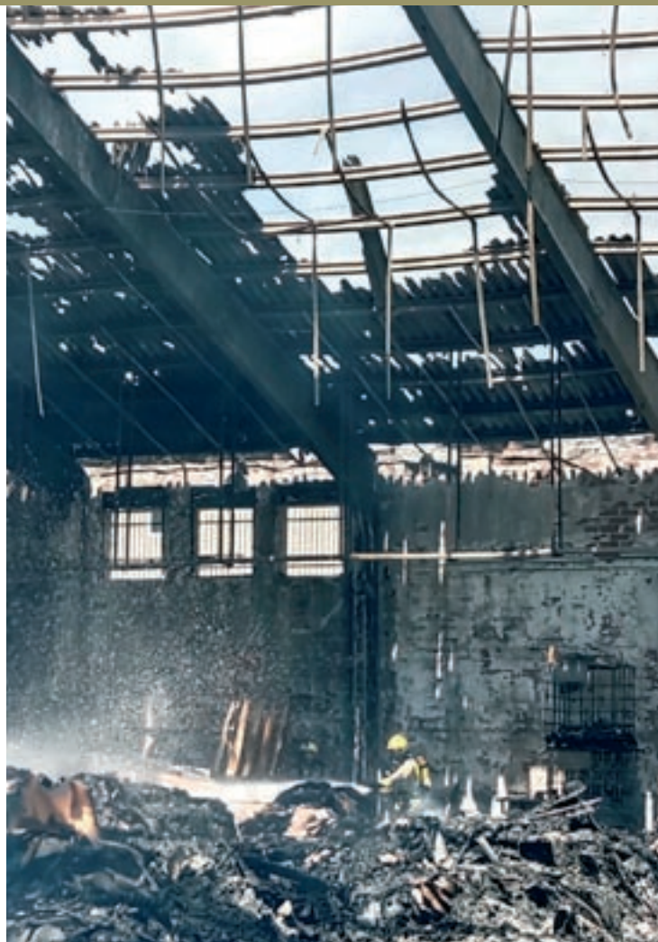
Un bomber treballant a l'interior de la nau en la fase final de l'extinció
