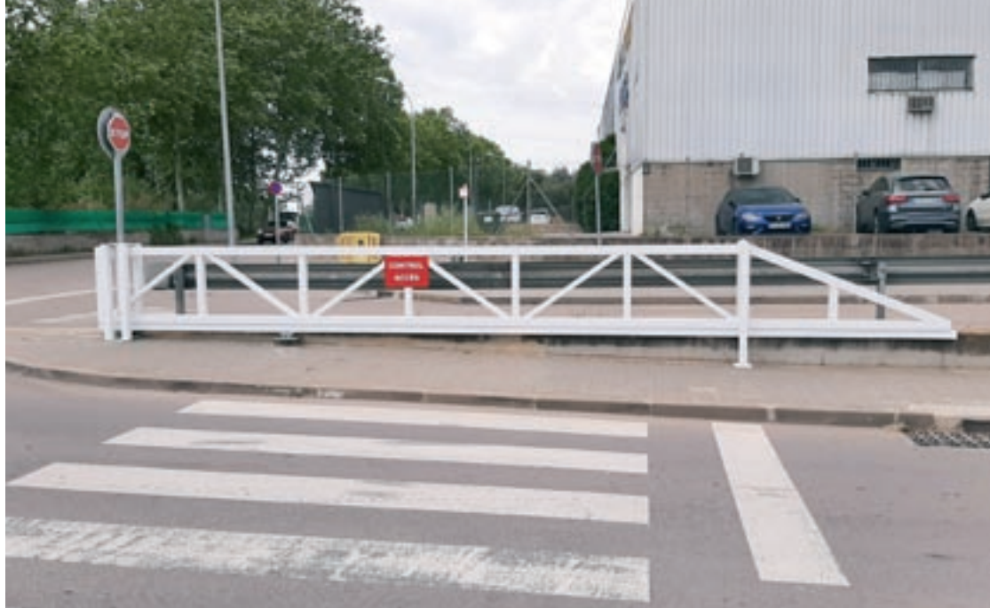
Les tanques que s'han col·locat al polígon Mogent per impedir l'accés amb vehicles
