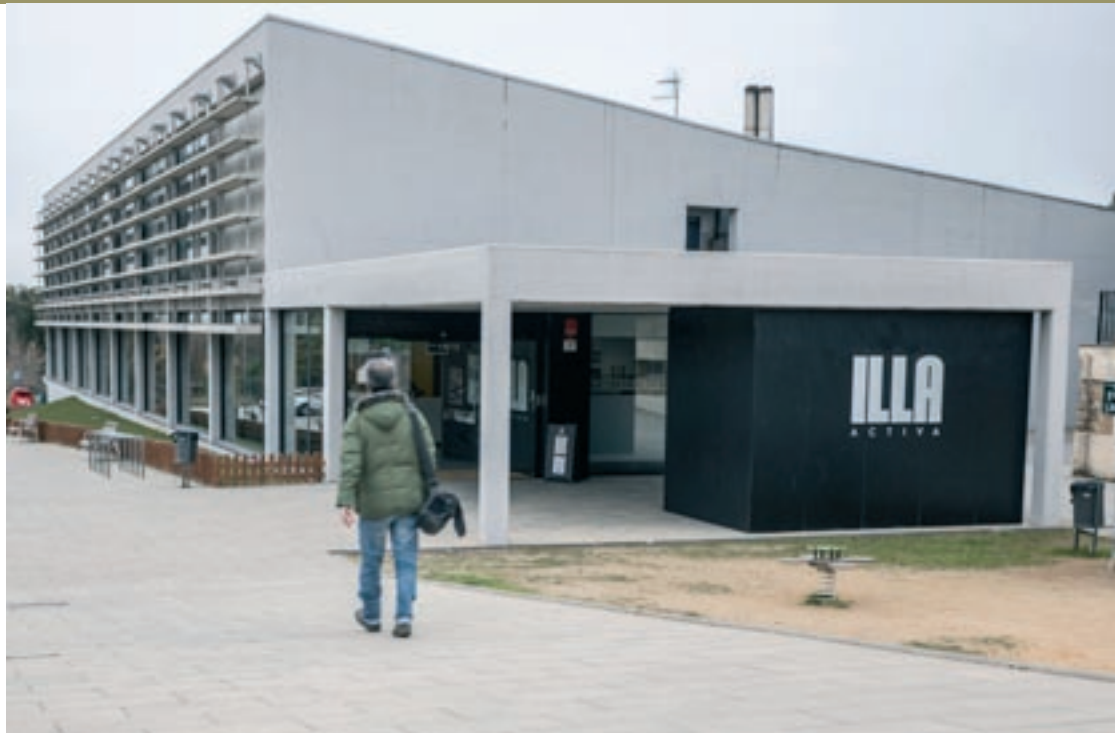
L'exterior del complex esportiu municipal de l'Ametlla
