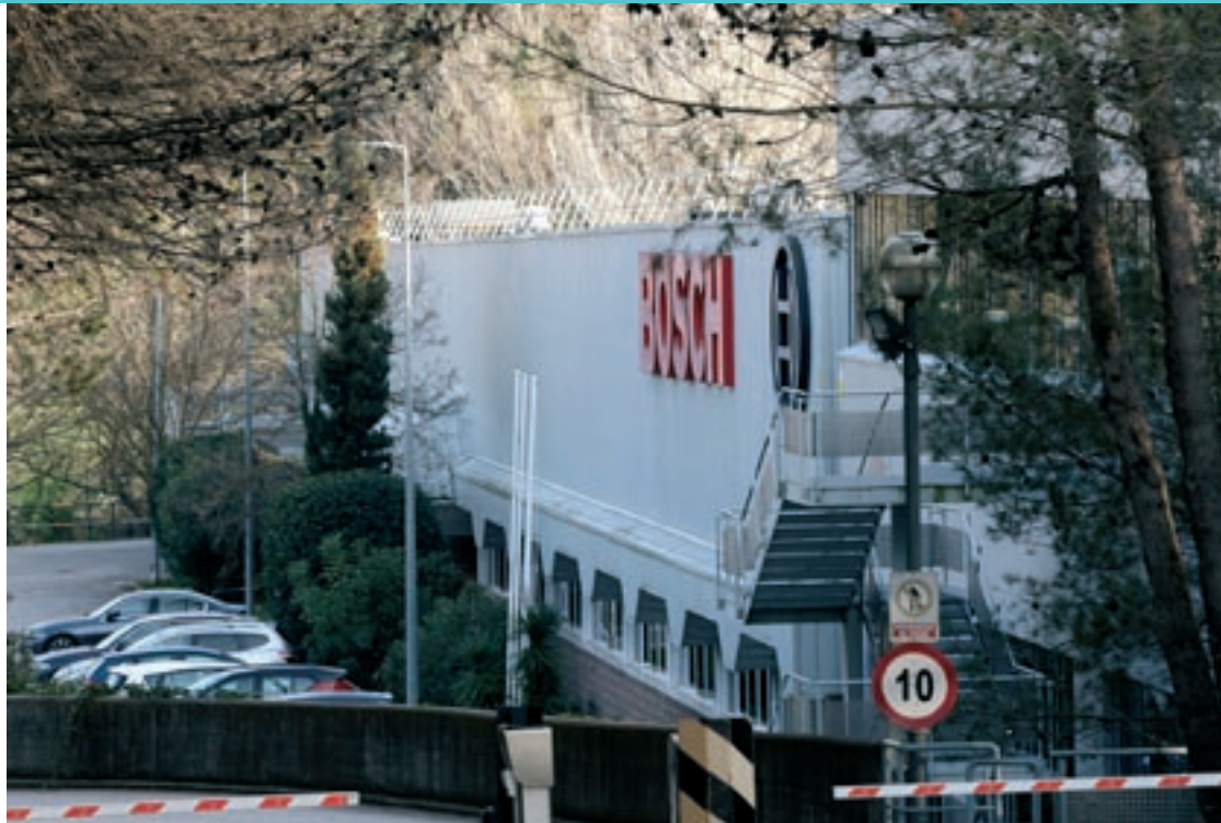
Aspecte de la fàbrica de Bosch a Lliçà d'Amunt
