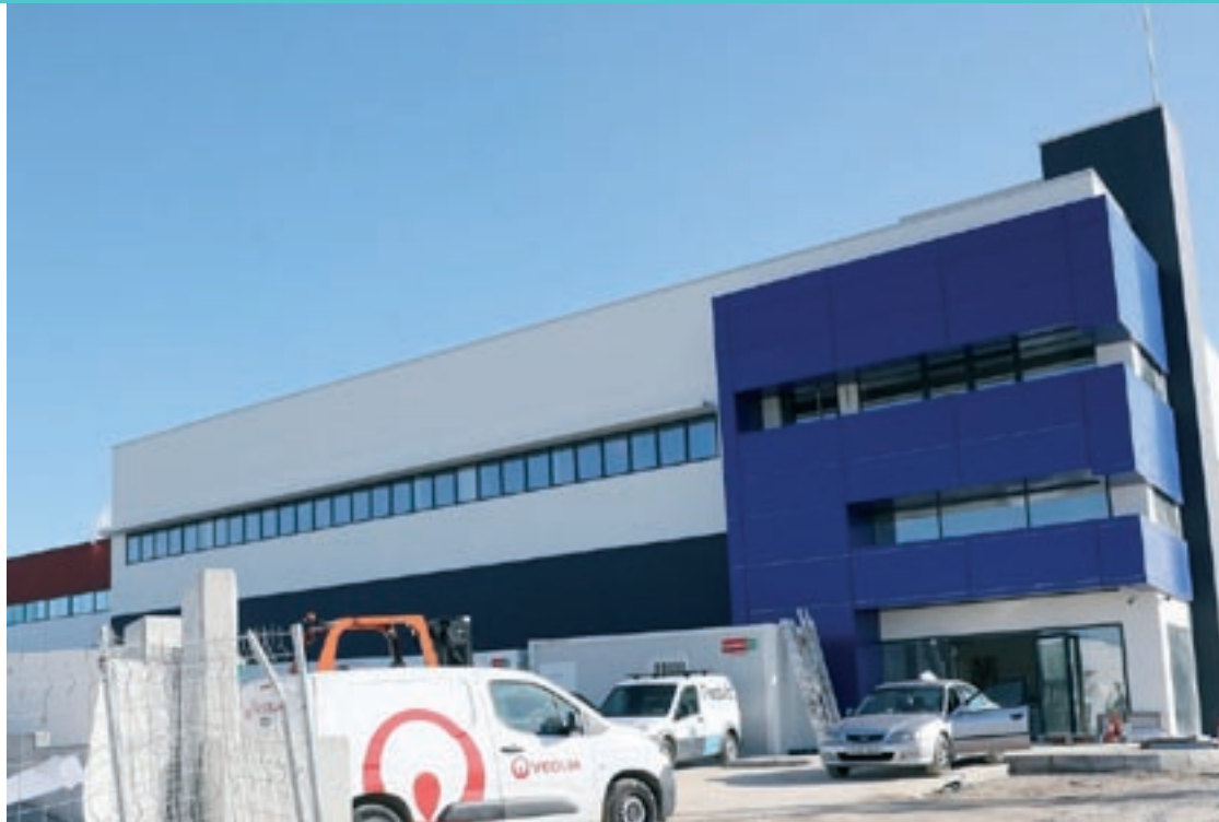
Instal·lacions de Frime a la Roca
