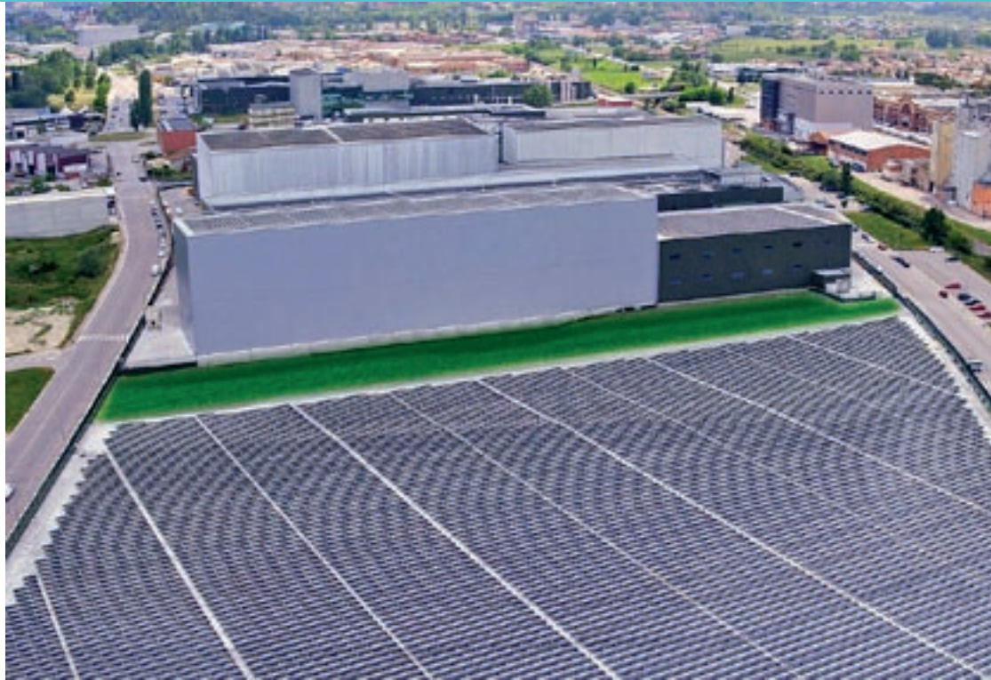
El nou parc solar està ubicat al costat del magatzem logístic robotitzat de Gurb
