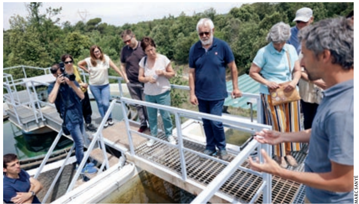
Un moment de la visita a la renovada planta potabilitzadora de Fontanelles, dimecres al migdia
