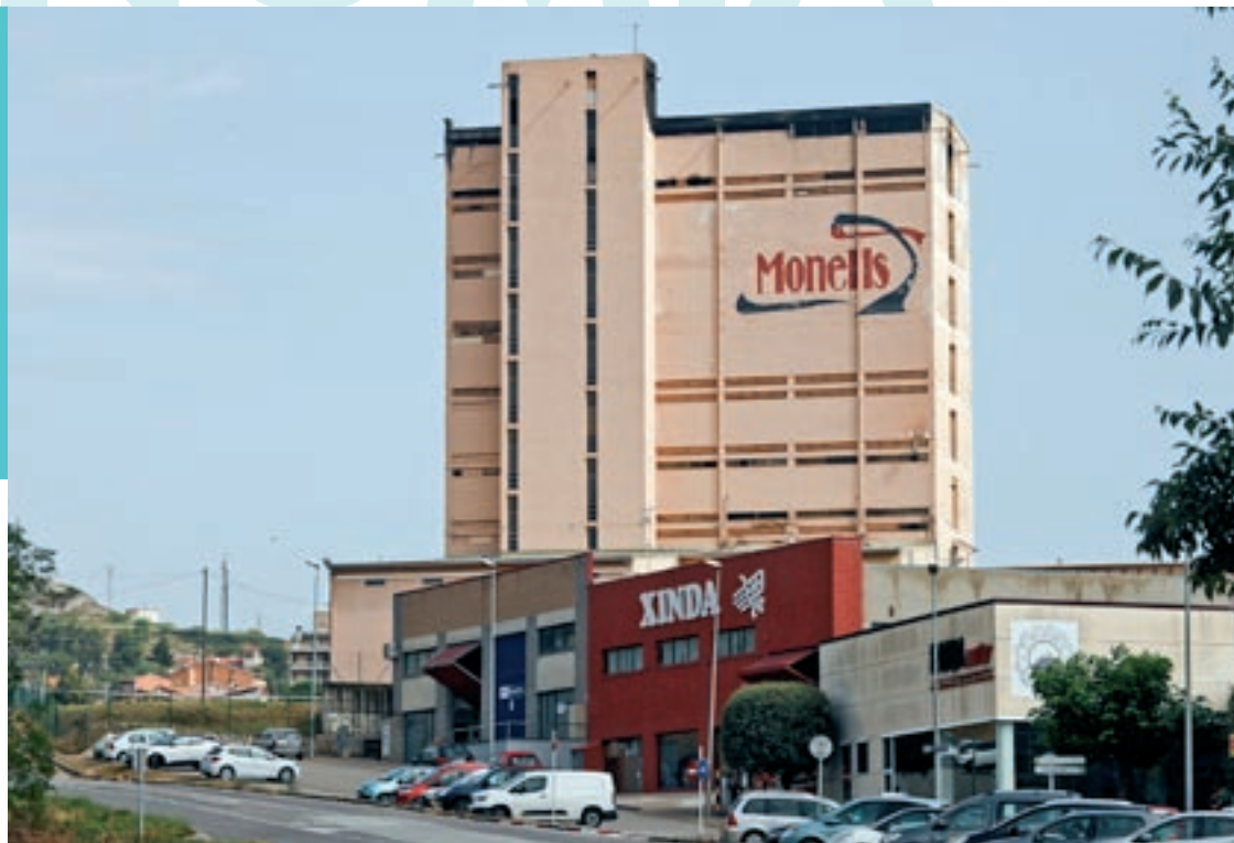
La planta d'Embotits Monells a les Masies de Voltregà. Al pis superior s'observa l'afectació de l'incendi
