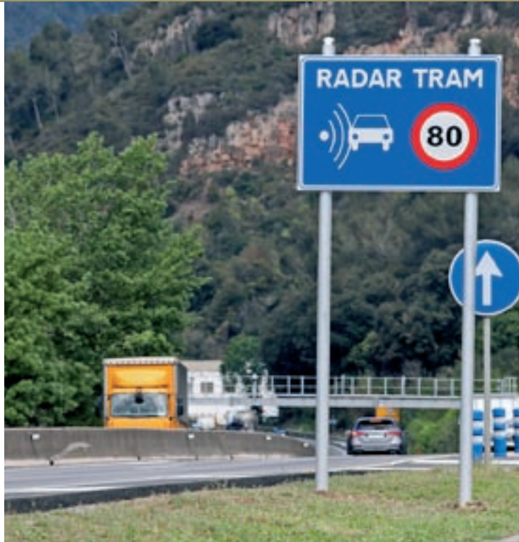
La senyalització del radar i, al fons, el pòrtic on hi ha les càmeres de control
