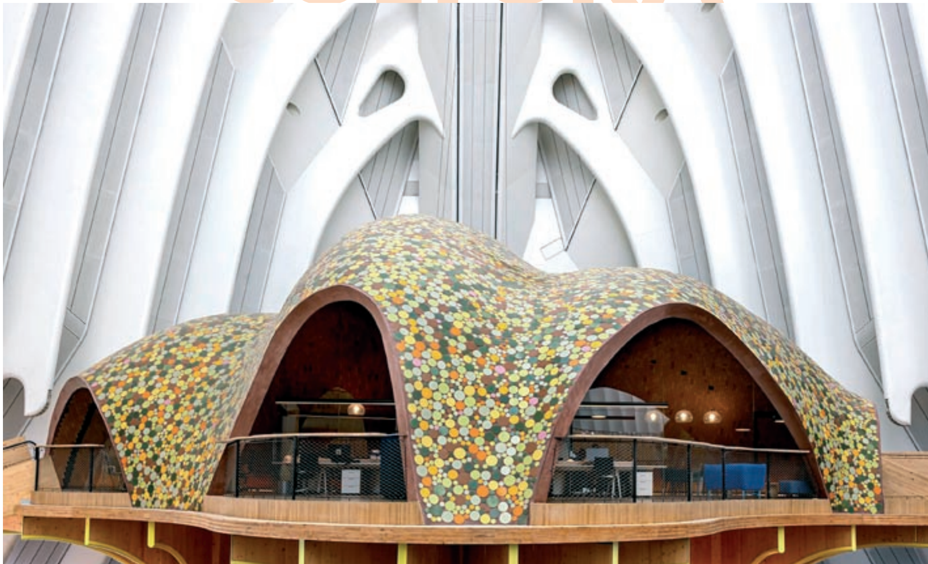
L'edifici d'administració del centre cultural Caixafòrum de València amb el revestiment fet per Ceràmica Cumella a base de peces circulars de diferents mides
