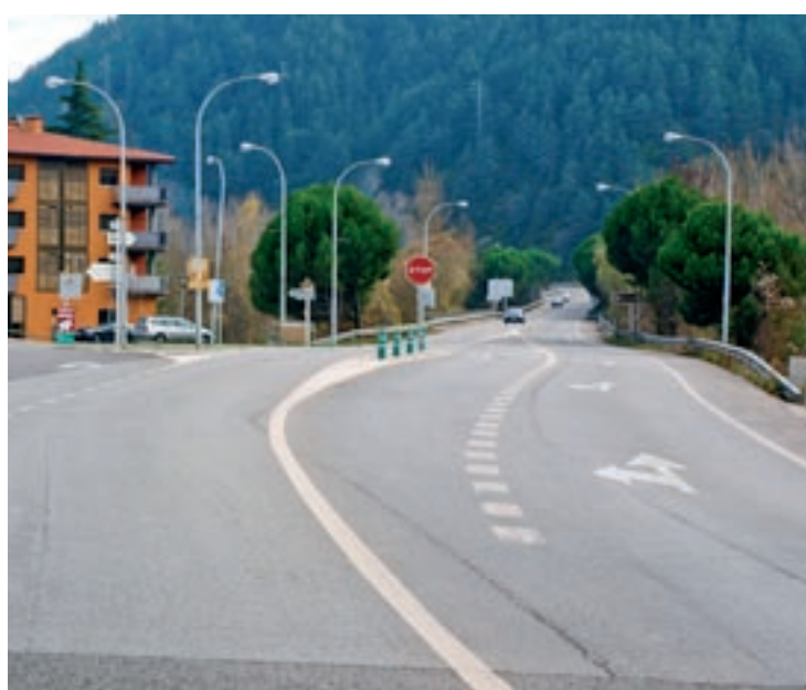
L'encreuament on s'ha de construir la nova rotonda
