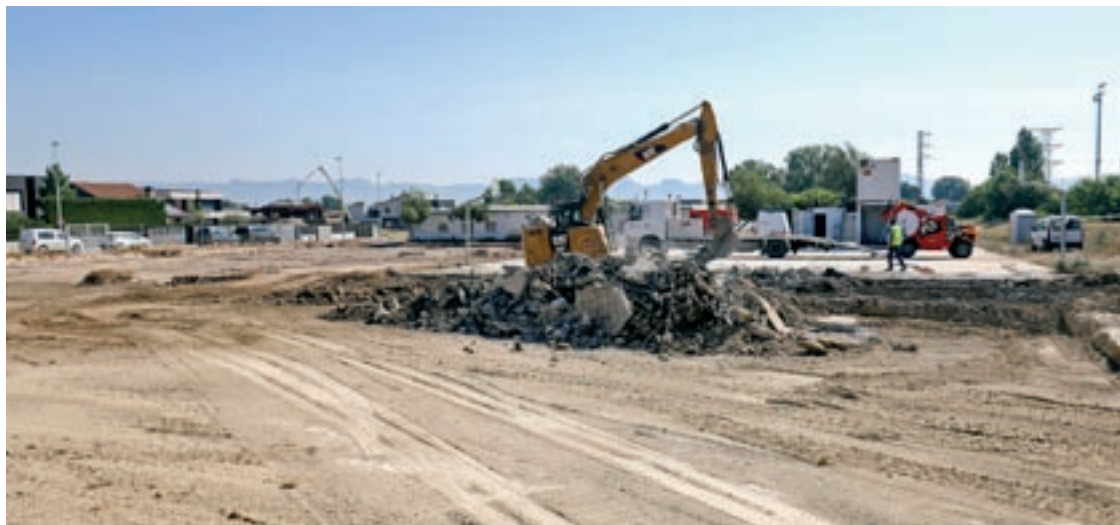
Les màquines treballant aquest dijous al terreny, al costat dels mòduls que es van instal·lar el curs 2010-11
