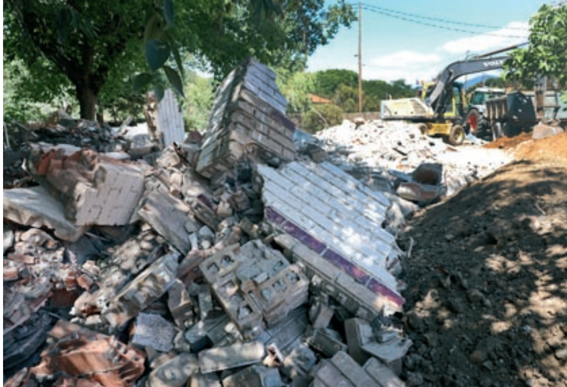
L'enderroc de la casa del conserge s'ha completat aquesta setmana, després de començar les obres el dilluns 21
