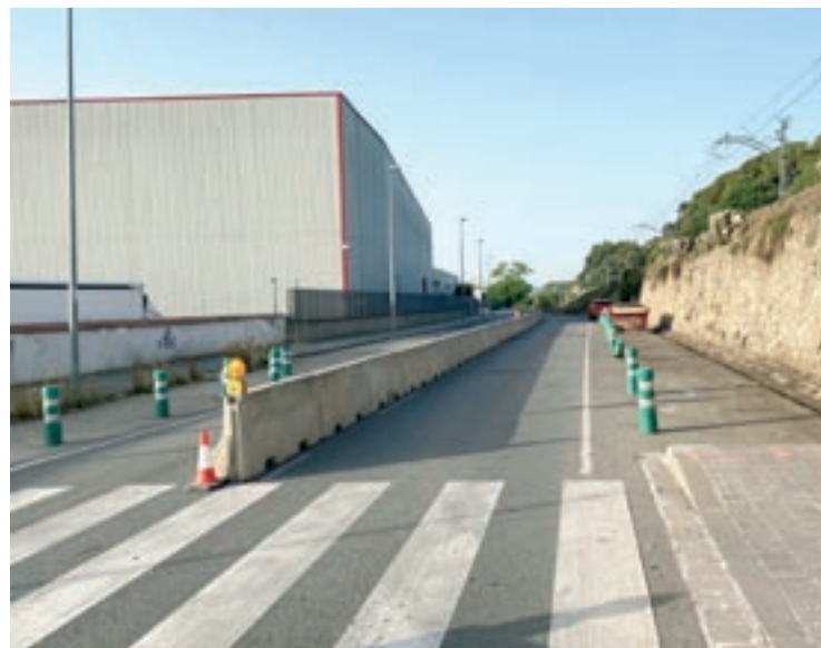
La restricció de la calçada a l'altura de l'edifici de la Seguretat Social
