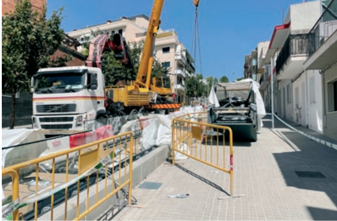
Una grua descarregava dilluns les rampes del tram central del carrer Carles Riba, a la Font Verda
