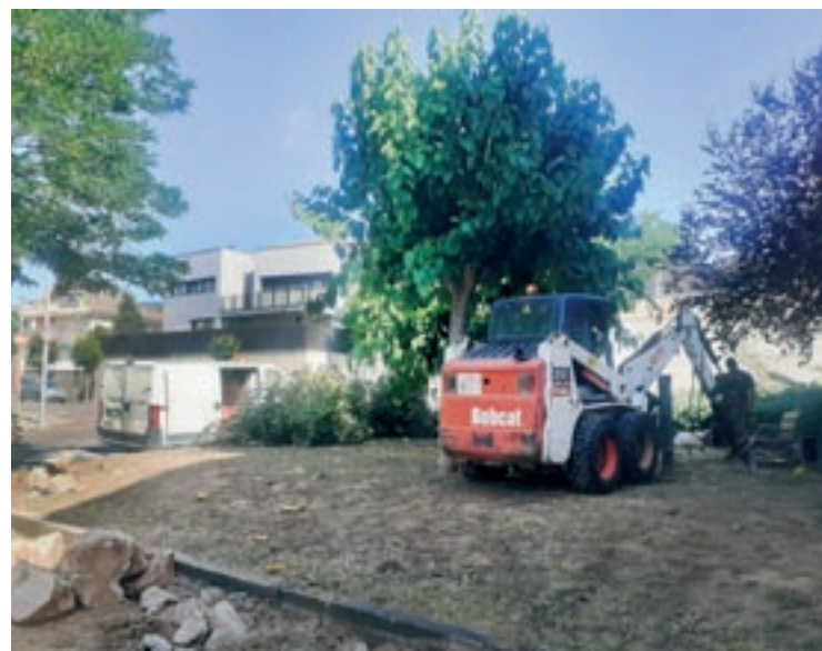
Els treballs inicials els ha fet la brigada municipal
