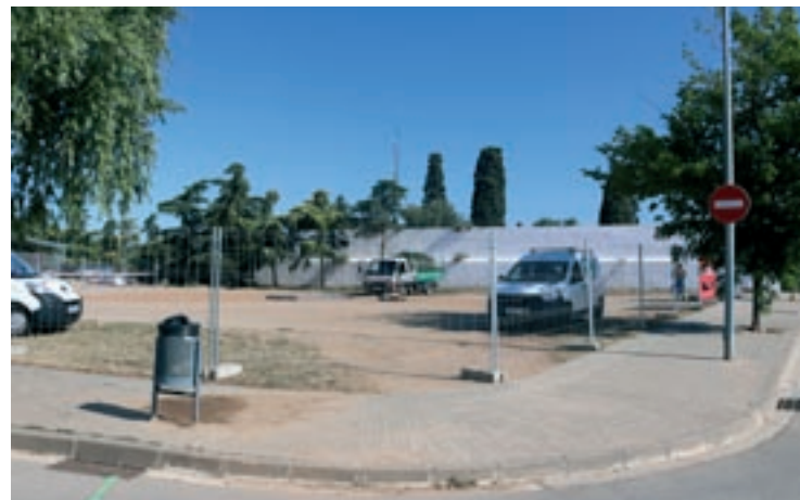
Inici de la primera fase d'ampliació del cementiri de Corró d'Avall
