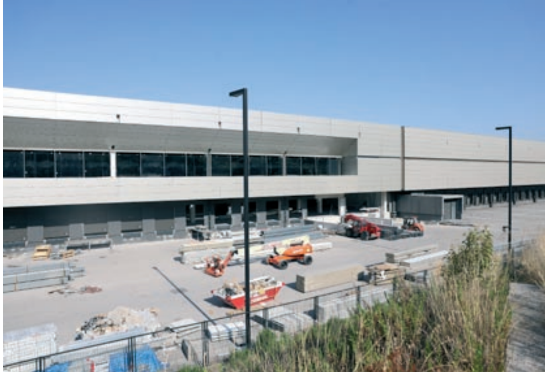
L'edifici de l'ampliació té les obres gairebé enllestides i ara s'esperen les inversions tècniques per començar l'activitat
