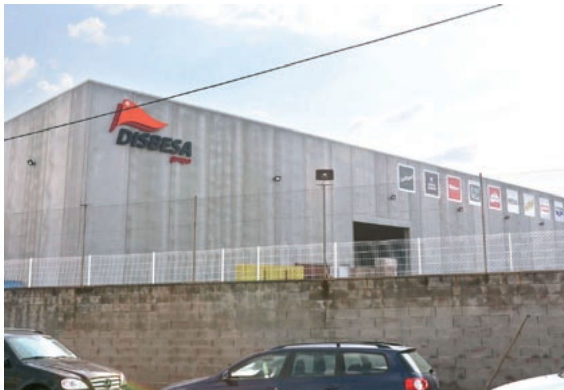
El grup va ampliar recentment les instal·lacions de Lliçà de Vall
