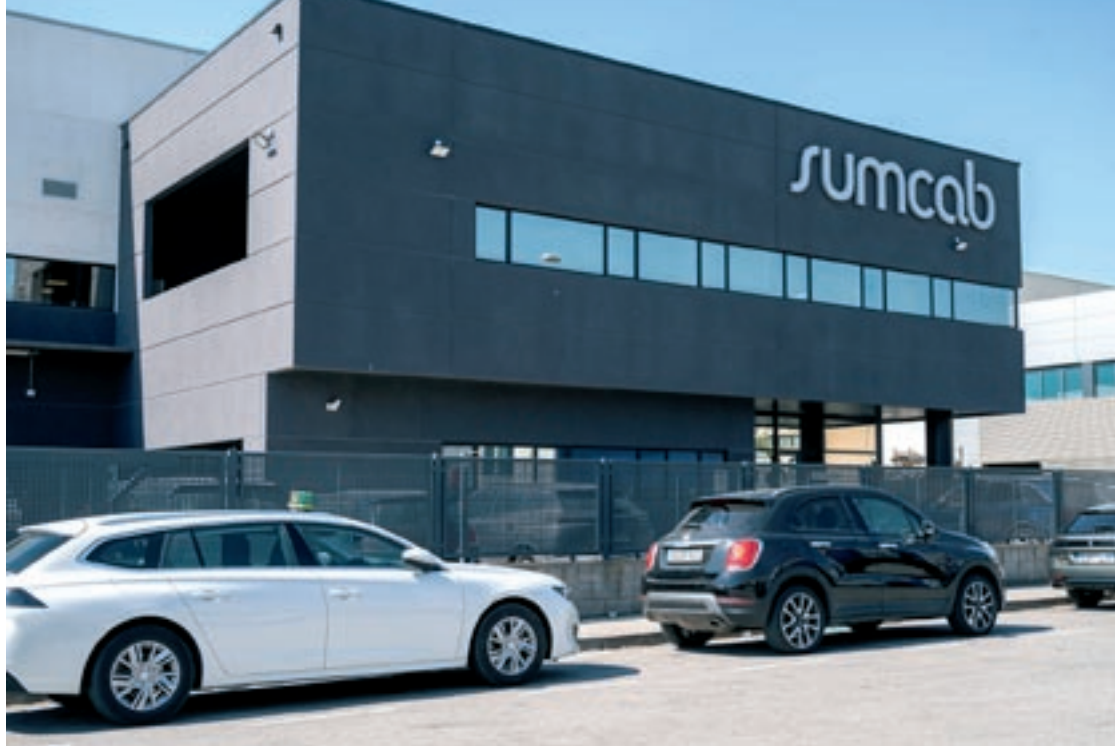
Instal·lacions de Sumcab al polígon del pla de Llerona, a les Franqueses
