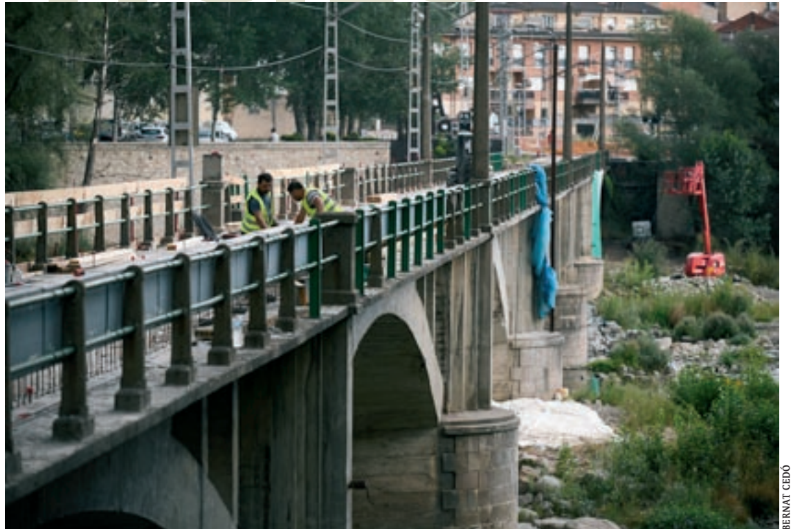
Una vista del pont del tren a Ripoll d'aquest dijous, als pocs dies d'iniciar-se les obres de reforma
