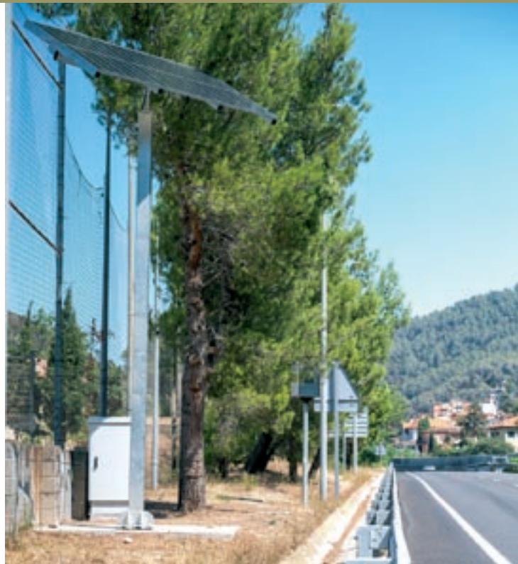
Les plaques solars que alimenten el nou radar de Figaró, que ja està en proves
