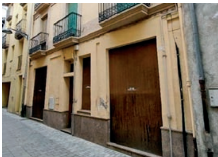
Vista de la façana de Cal Dimoni a Sant Quirze de Besora
