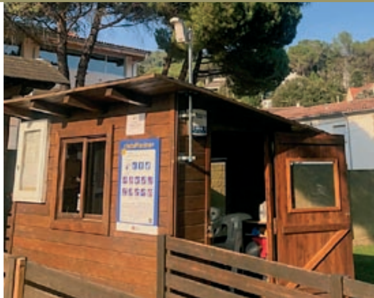
Un dels aparells del sistema d'alarma instal·lats al recinte de les piscines
