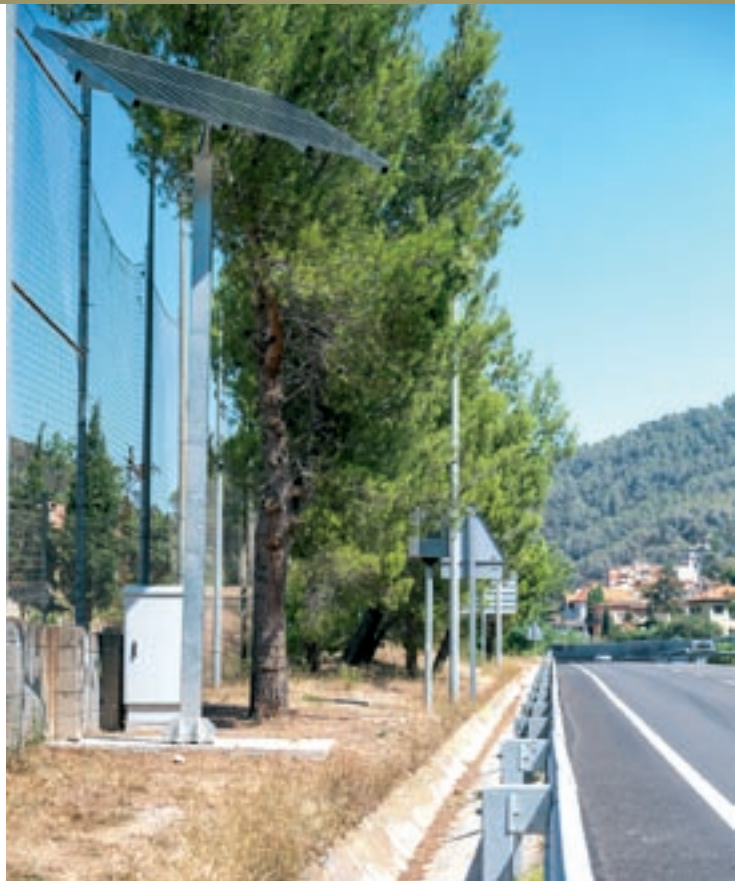
Les plaques solars que alimenten el nou radar de Figaró, que ja està en proves
