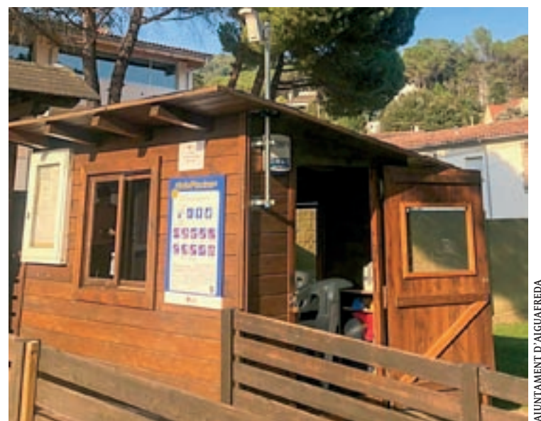
Un dels aparells del sistema d'alarma instal·lats al recinte de les piscines
