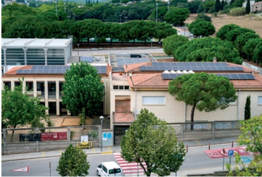
Les cobertes de l'escola Les Llisses, amb les plaques solars instal·lades, des de l'Ajuntament de Llicà de Vall
