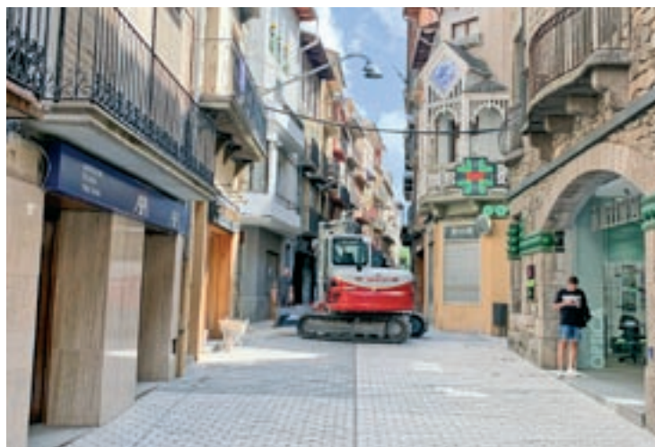
Una màquina treballant al carrer València
