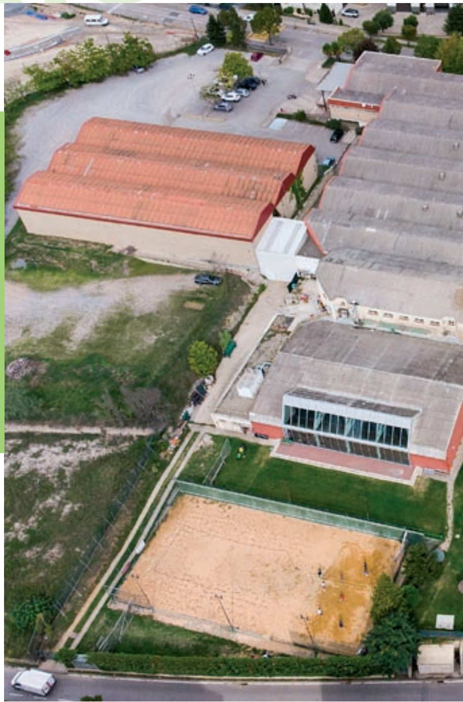
Imatge aèria de les instal·lacions del Club Patí Vic, que ara passaran a ser municipals
