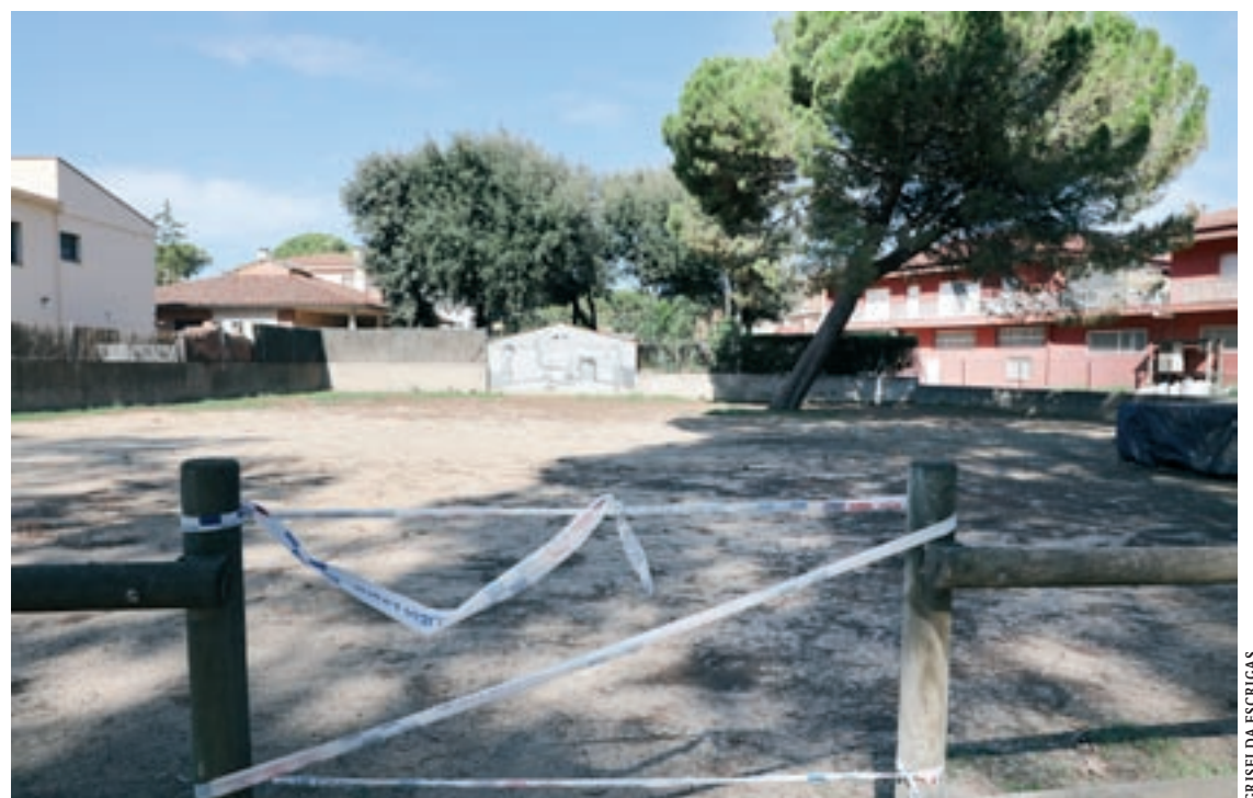
La plaça dels Encants ha estat tancada en els darrers dies a l'espera de l'informe tècnic sobre l'estat d'un arbre
