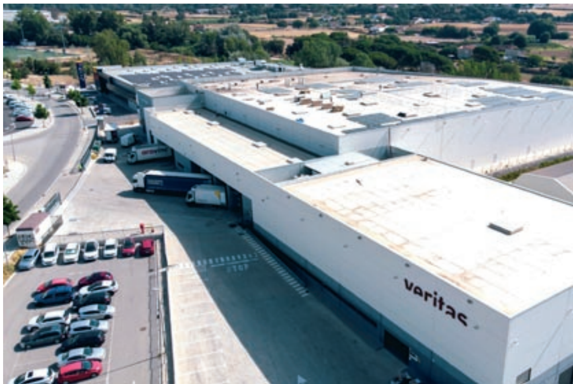
La planta logística de Veritas de Lliçà d'Amunt
