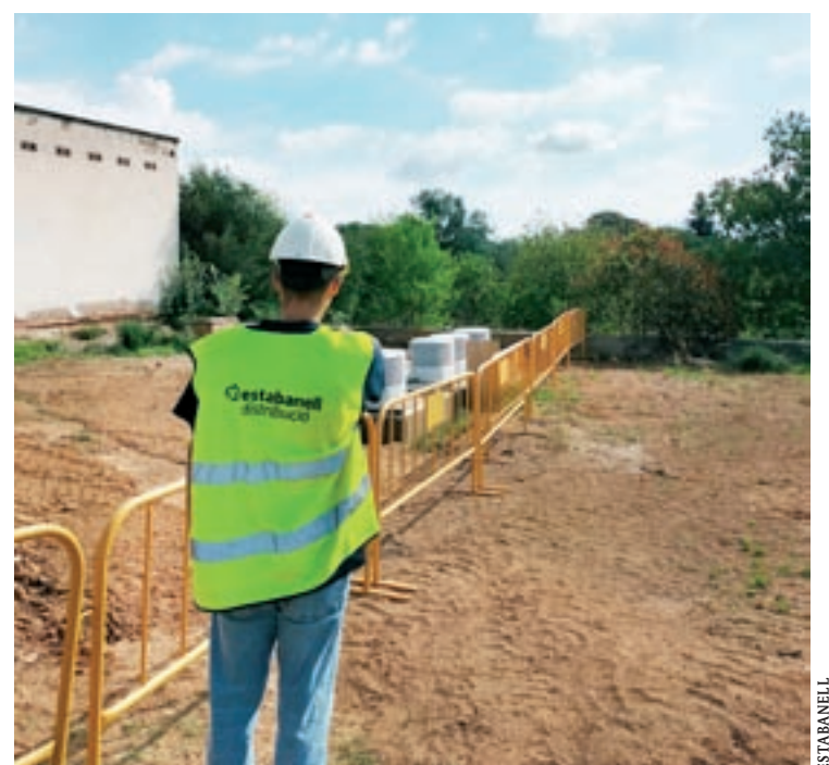
L'empresa ja està fent els treballs de soterrament
