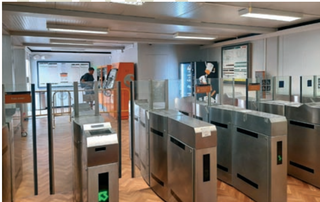
Les noves instal·lacions provisionals que permeten l'accés a les andanes i que funcionaran fins a la primavera de 2023
