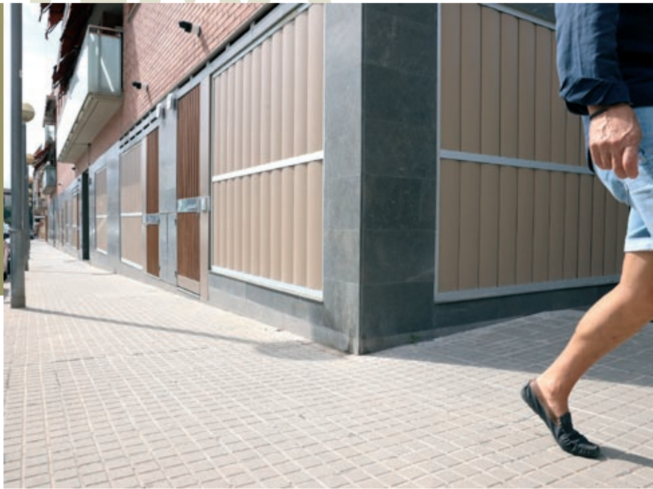
D'esquerra a dreta, un local comercial reconvertit en habitatge al número 43 del carrer Bartomeu Brufalt; l'edifici Pous, a la plaça Pau Casals
