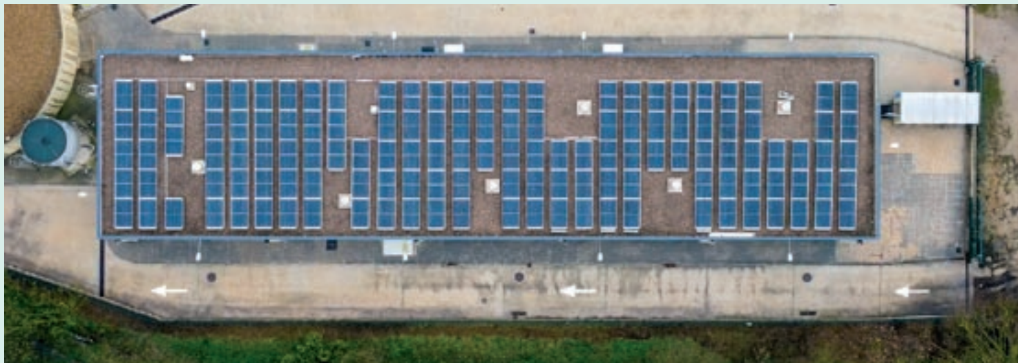
Plaques fotovoltaïques instal·lades a l'Estació de Tractament d'Aigua Potable de Sant Celoni.
