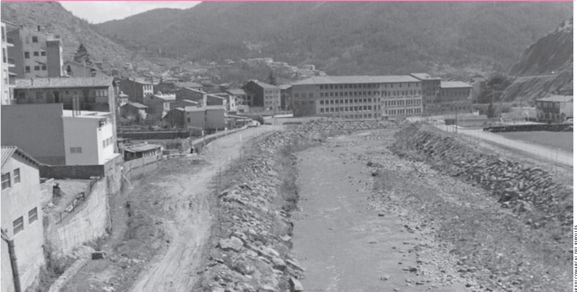
ARXIU COMARCAL DEL RIPOLLÈS
