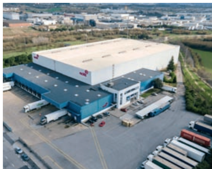
Instal·lacions logístiques de Reckitt a Lliçà de Vall
