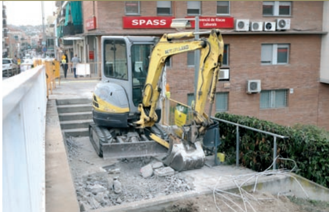
Aquesta setmana es fan obres de construcció d'una nova connexió d'aigua al carrer Francesc Ribas
