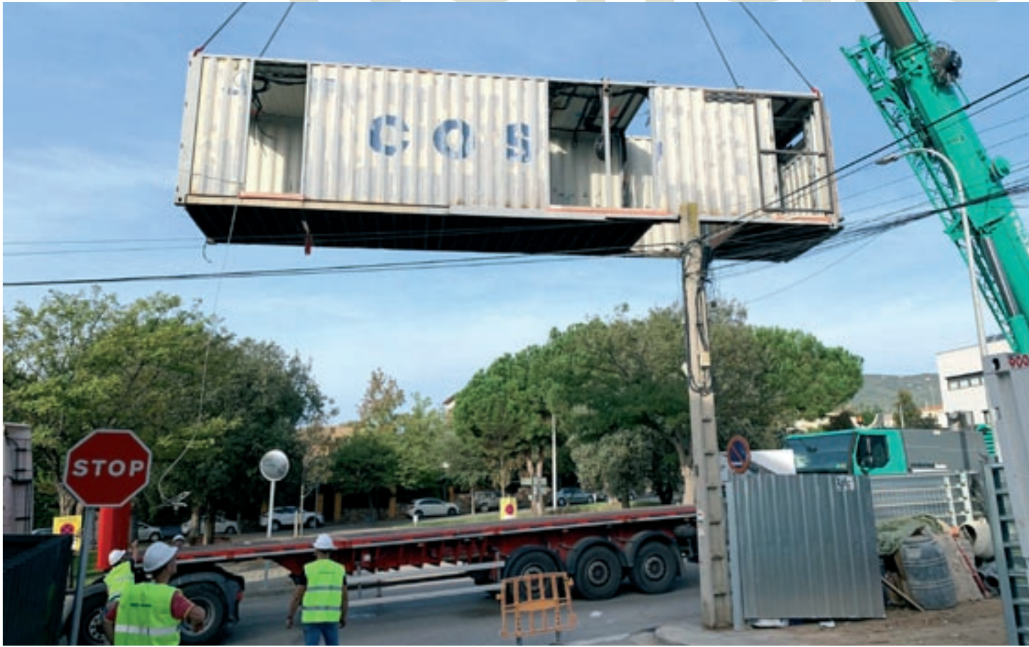
Els contenidors marítims es van instal·lar davant del parc Romà Martí fent servir una grua de grans dimensions
