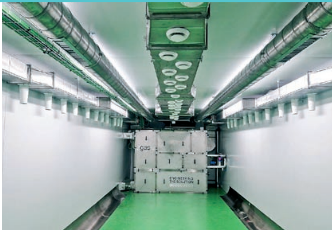
El sistema ideat per GasN2 instal·lat en una cambra d'assecatge buida
