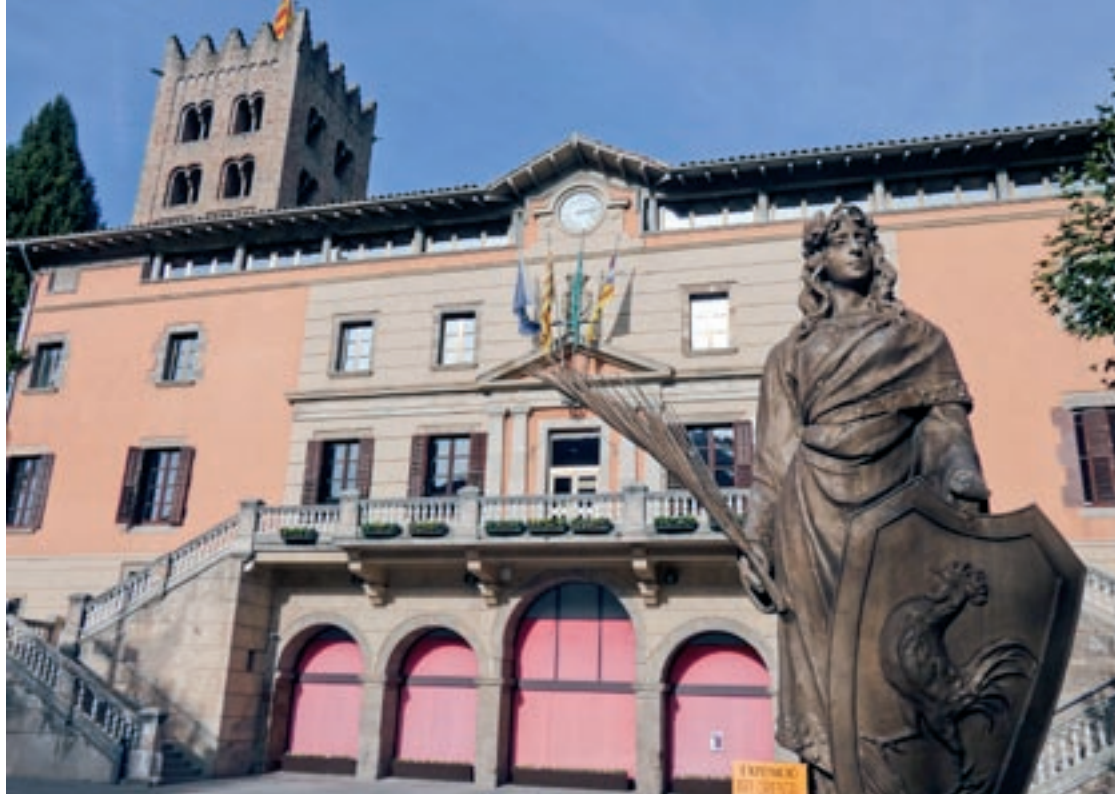
Vista de la façana de l'ajuntament de Ripoll, on s'havia de fer la reforma
