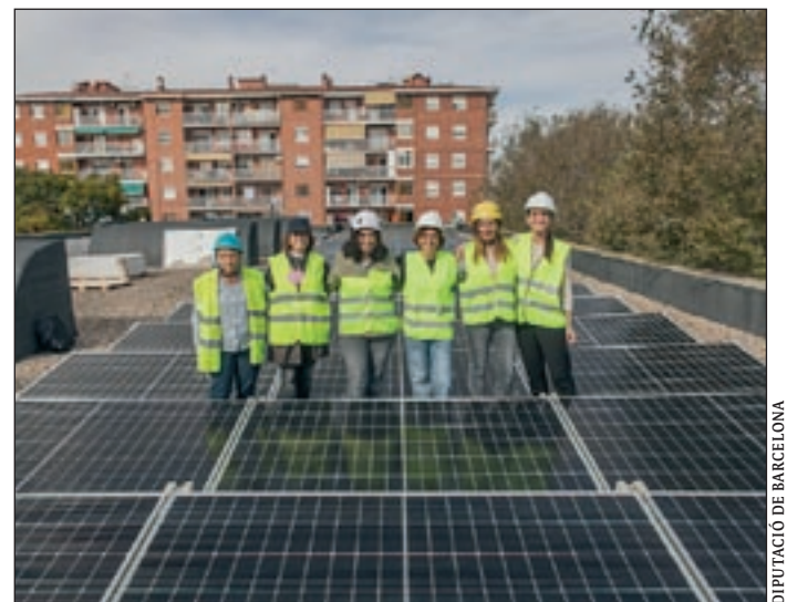
Equipaments sostenibles. Plaques solars a la coberta de l'escola Charles Darwin del Prat de Llobregat
