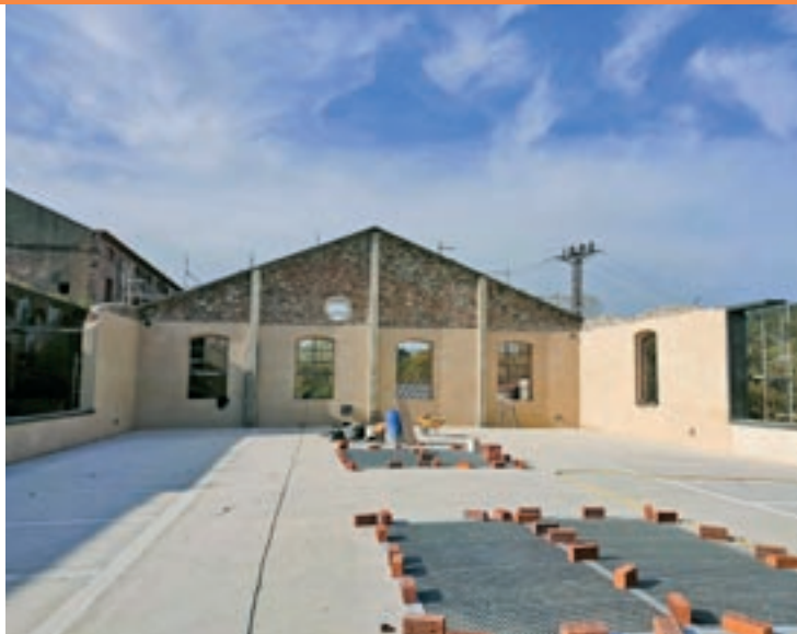
Aspecte exterior de la nau on s'ubicarà el futur Museu Llaudet
