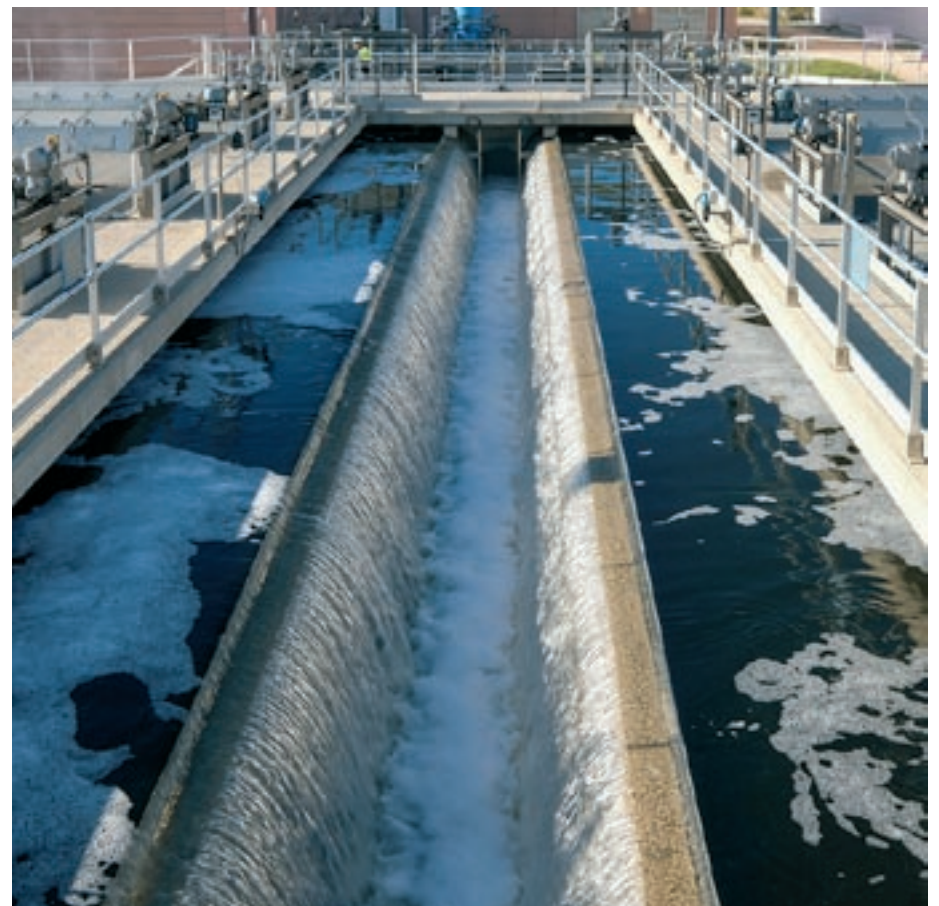
Primera fase del tractament de regeneració a l'EDAR del Baix Llobregat
