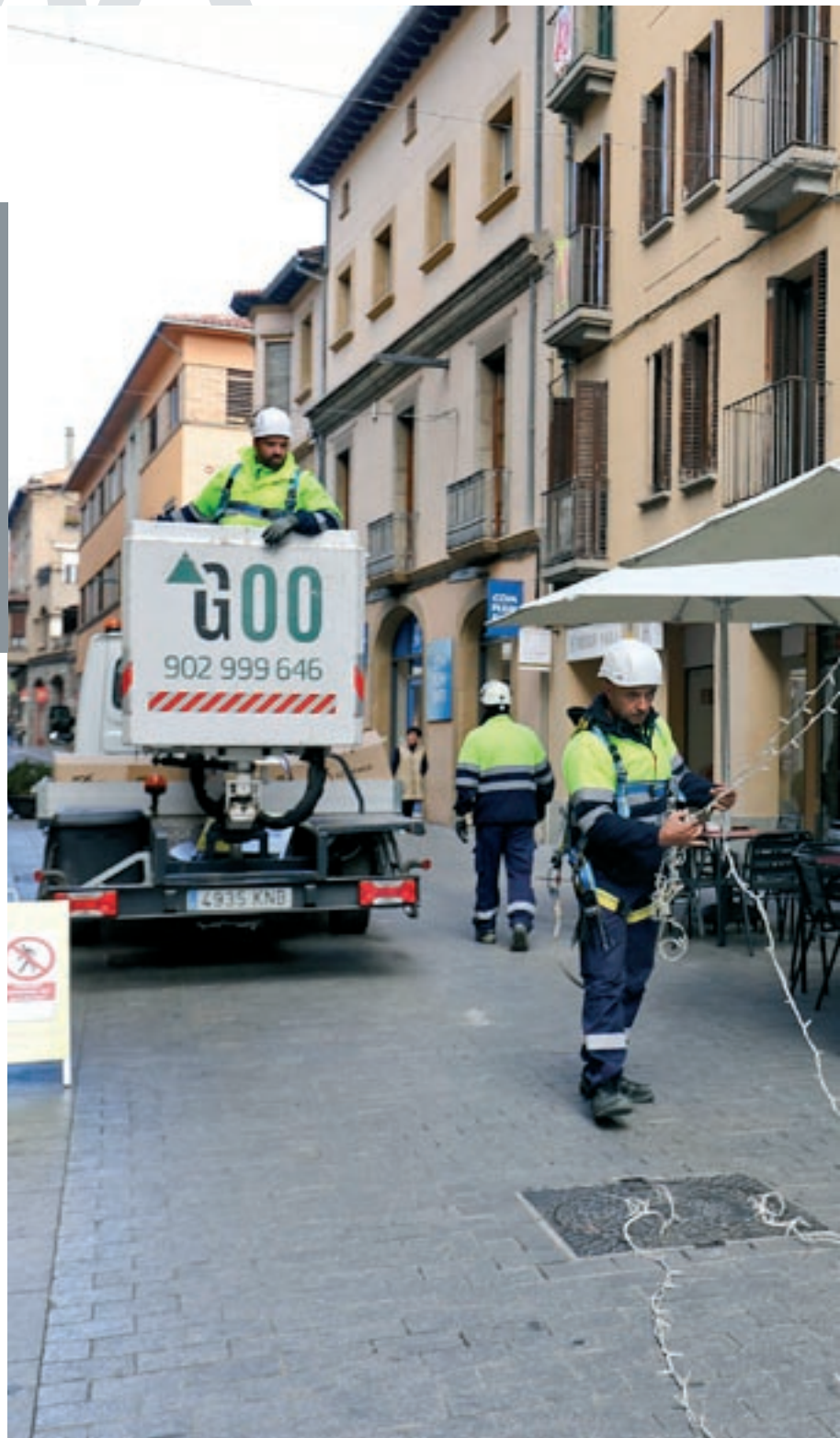
Treballadors de Minsvic, col·locant il·luminació de Nadal al carrer Manlleu de Vic aquest dijous
