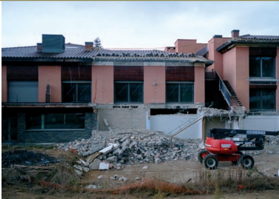
La nova etapa d'enderrocs a l'hotel de la Roca ja era ben evident la setmana passada
