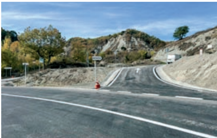
Imatge del nou accés a la carretera de Muntanyola des de l'N-141c
