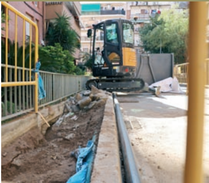
Els treballs de renovació de la canonada del carrer Juan de la Cierva
