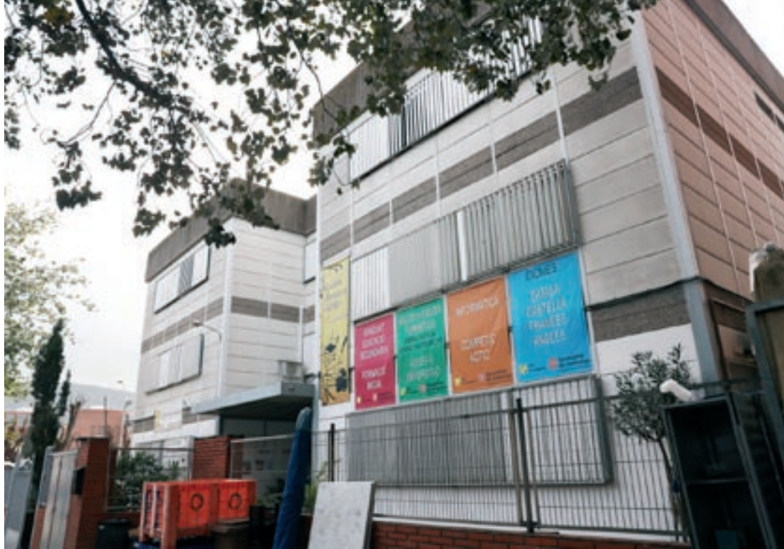
Exterior de l'edifici de l'escola d'adults de la Llagosta, aquest dijous al matí
