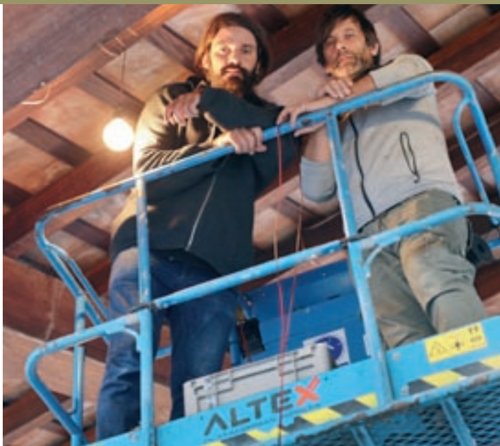
Xevi Bayona i Emi Martínez muntant la instal·lació de la Porxada
