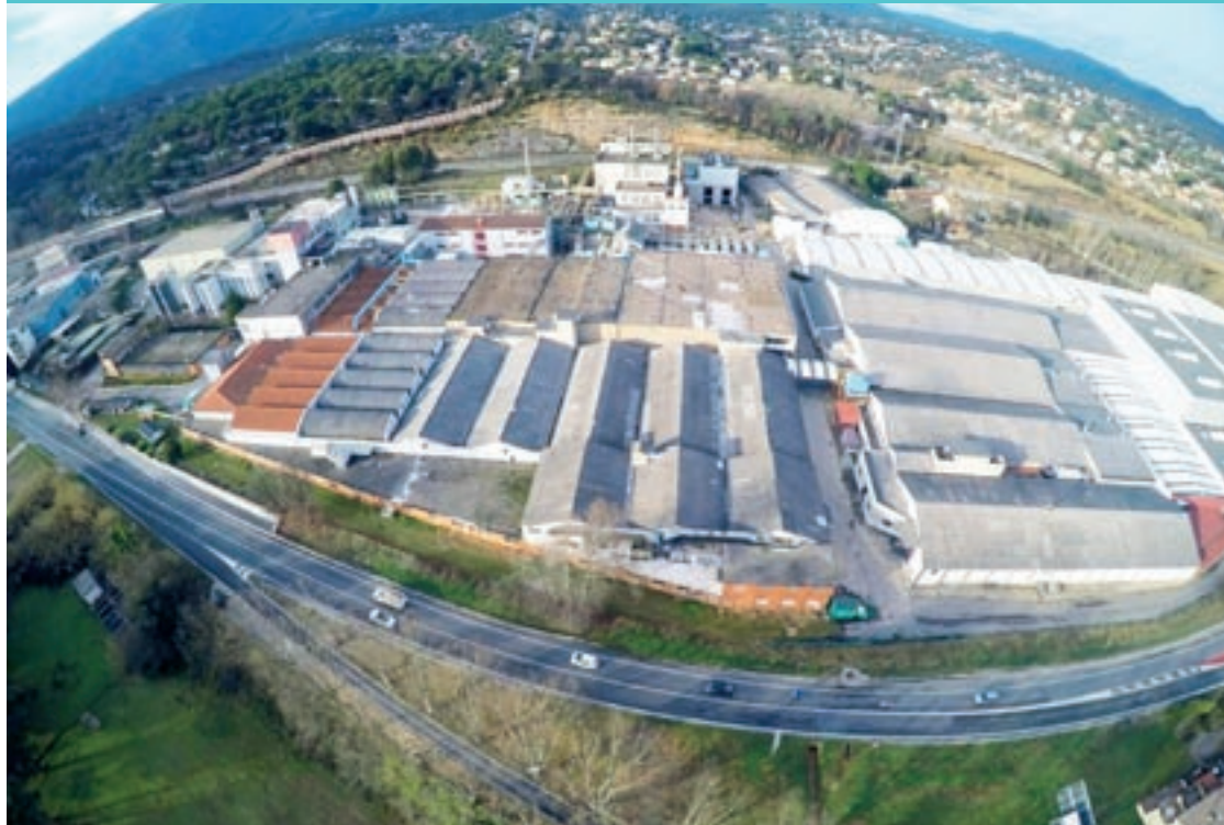
Una imatge aèria de les àmplies instal·lacions que l'antiga Inacsa té a la Batllòria
