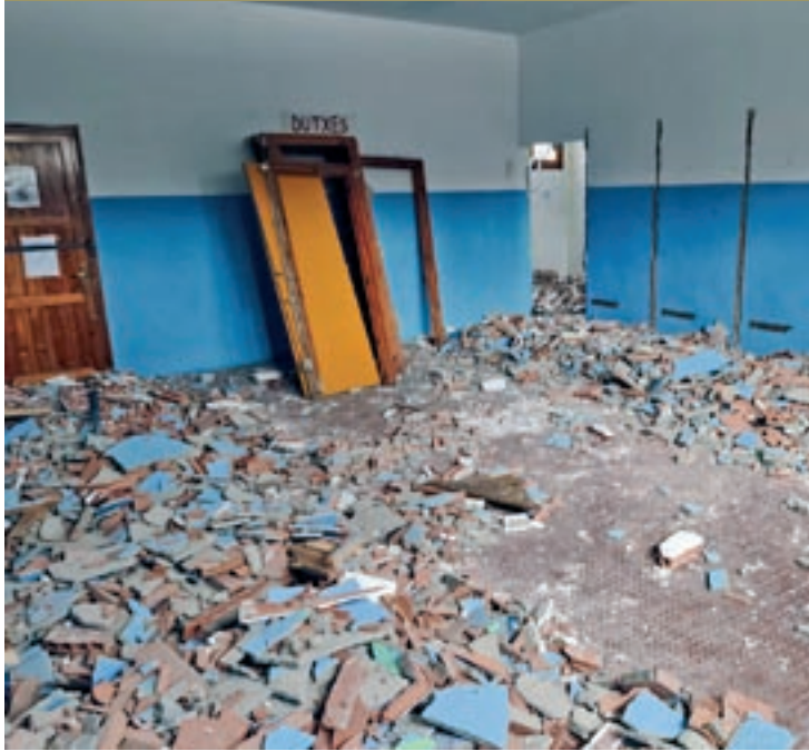
Els vestidors, un cop iniciades les obres de reforma
